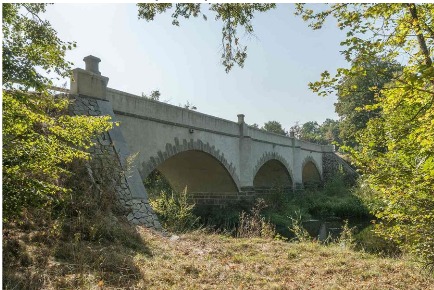
Obrázek č. 5 Kamenný most přes Skalici
